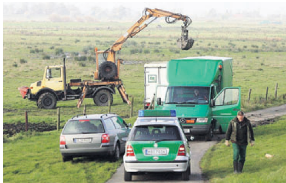
Mit einem Bagger wurde die Bombe auf einer Weide am Ochtumdeich aus zweieinhalb Metern Tiefe ausgegraben. Das Gelände war in einem Umkreis von 500 Metern evakuiert.
